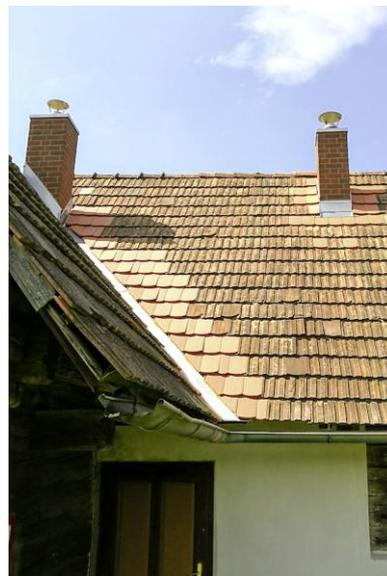
Der Altbestand wurde fachgerecht komplett abgetragen, und durch ein 5,5 Meter langes Leichtbausystem AHRENS Kompakt LBS-F ersetzt. Im Dachgeschoß wurde der Kamin mit Sparrenhaltern fixiert und über Dach mit einem Stülpkopf versehen. Zum Schluss erhielt der Kamin im Erdgeschoß einen weißen Verputz.
