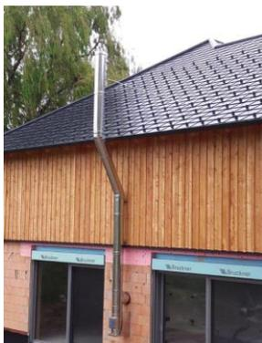
Um den Dachvorsprung nicht zu durchdringen, wählte Leopold Plank als Lösung die Errichtung eines Außenkamines **AHRENS Kompakt** mit Bögen, einem Durchmesser von 200 mm und einer Höhe von rund 8 Metern.
