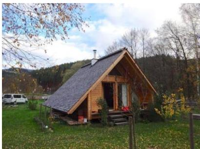
Eine besondere Herausforderung stellte die Bauweise sowie spezielle Dachkonstruktion des Gartenhauses dar: es handelt sich hier um ein Holzhaus mit Holzschindeldeckung, d.h. natürlich erhöhte Brandgefahr, wenn das Kamin- und Abgassystem nicht fachmännisch gelöst wird.
