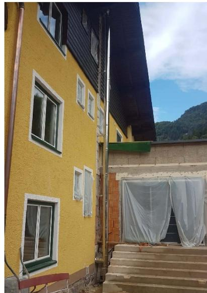
Bei der Sanierung des Mehrfamilienhauses in Scheffau war die Aufgabe für Alexander Cernik bzw. das Technik-Team von AHRENS den bestehenden Kamin zu demontieren und durch einen Edelstahlkamin DW ECO mit DM 16 zu ersetzen. Auch dieser hatte eine stattliche Höhe von 12 Metern.
