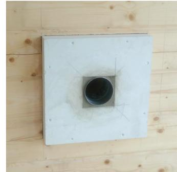
Gut ersichtlich sind die erforderlichen Brandabstände und der richtig eingebaute DWD-Brandschott bei der Wanddurchführung. Doppelte Sicherheit für die Hausbesitzer: ein System vom Profi geliefert und eingebaut und damit Unabhängigkeit von den Launen der Natur ...
