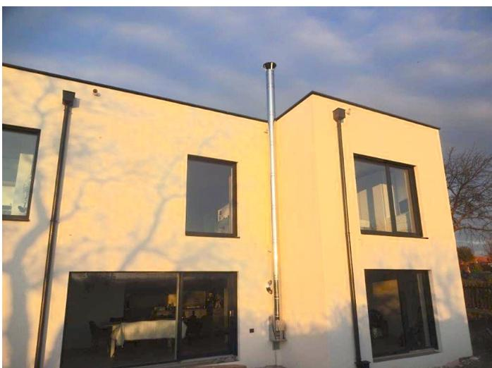
Um den Wunsch einer weiteren Wärmequelle zu erfüllen, wurde der doppelwandige Edelstahlkamin AHRENS Kompakt mit einem Durchmesser von 18 cm errichtet.
