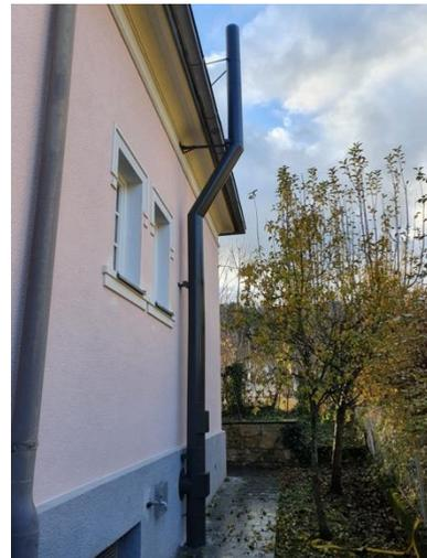
Beim Wohnhaus im Bezirk Scheibbs wurde ein **AHRENS Kompakt Style** montiert und im Winkel von 30° über den Dachvorsprung geführt. Die Abstützung erfolgte über Dach, um die Kaminanlage sicher zu verankern. Der AHRENS Kompakt Style ist nicht nur ein optisches Highlight – er ist auch äußerst praktisch und vielseitig obendrein. Durch die eingezogenen Steckenden des Außenrohres kann ohne Klemmbänder aufgebaut werden. Eine perfekte Dämmung und der vielfältige Einsatz ergänzen die Erfolgsbilanz.
