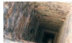
Der vorhandene Kamin muss zur Auskleidung mit dem Sanierungsreliner durch AHRENS entsprechend vorbereitet werden.
