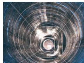
Der Querschnitt des Sanierungsreliners und seine geometrische Form können auch innerhalb eines einzigen Schachtes mehrfach verändert werden.
