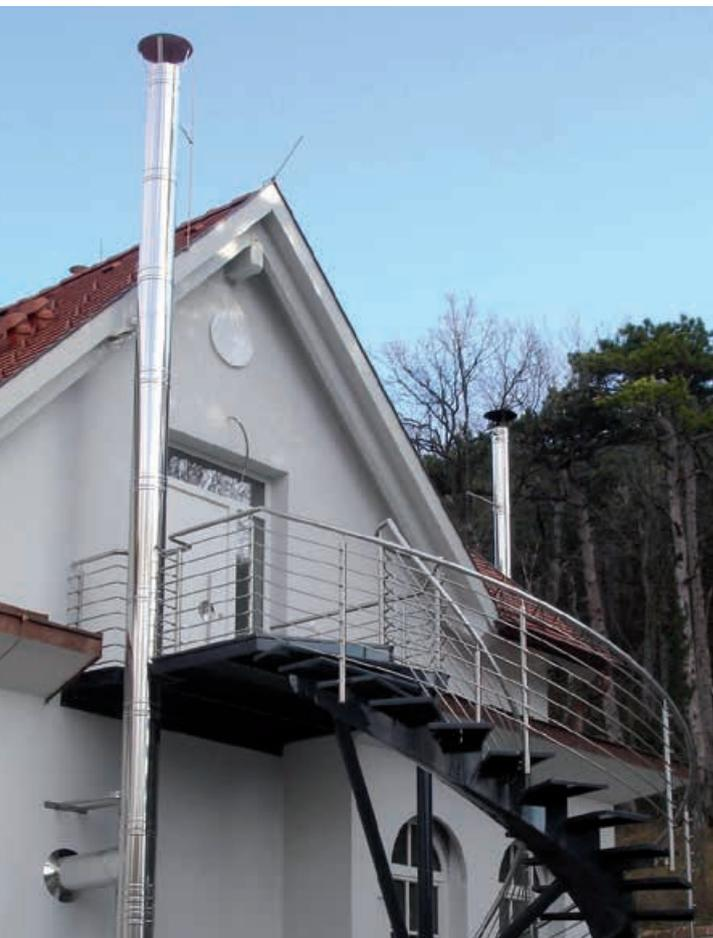
Der AHRENS Edelstahl Kompaktkamin besteht aus einem hochwertigen Edelstahlaußenrohr und einer mineralischen Wärmedämmung. Das Innenrohr ist entweder aus Edelstahl oder Keramik. Die jeweils verwendete Materialqualität der Innenschale garantiert eine lange Lebensdauer. Die zwischenliegende mineralische Wärmedämmung ist hochtemperaturbeständig und im Ausbrennversuch mit einer Temperatur von 1000°C geprüft.
