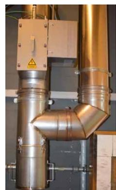
Vertikaler Einbau mit Staubsammelbox
